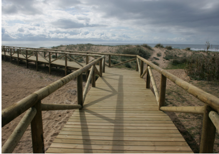
Pasarela en Playa Los Caños (Barbate, Cádiz)
